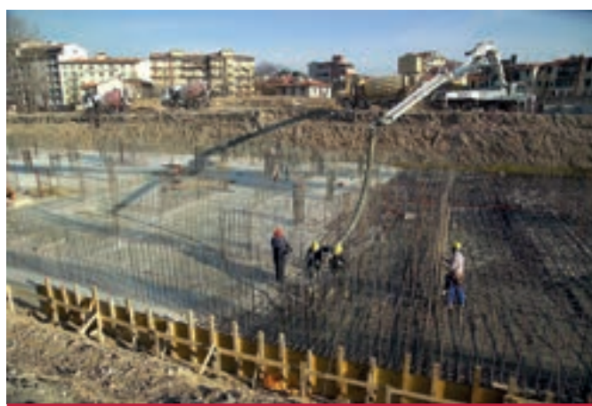
Realizzazione fondazioni edificio a Firenze
