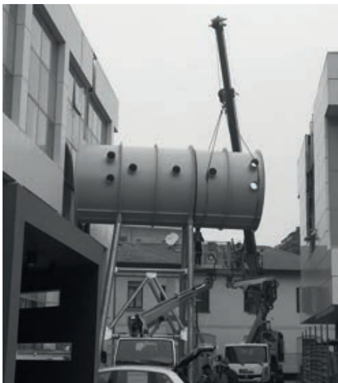
Viale Monza a Milano - Riqualificazione edificio mq 6.000 ad uso direzionale
