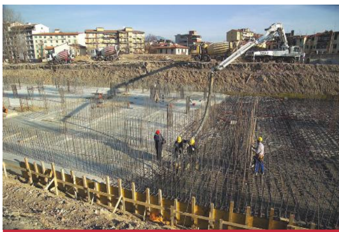
Realizzazione fondazioni edificio a Firenze
