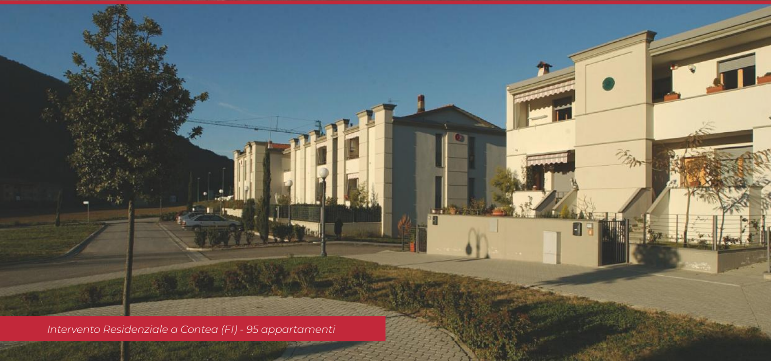
Intervento Residenziale a Dicomano (FI) – 82 appartamenti
